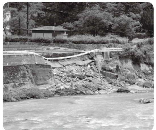
上越方の災害現場
