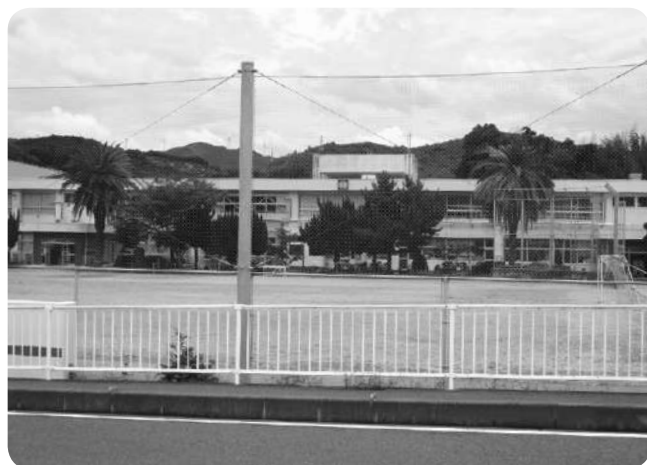
トイレ改修が始まる川辺西小学校
